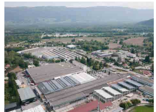
Carrier - usine de production de Culoz - Culoz production plant Produktionsstätte in Culoz
