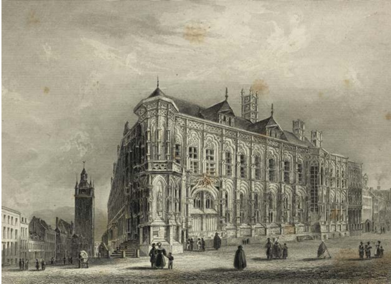
Géographie 1841 - Ref. : 36023 Hôtel de Ville de Gand - Ghent City Hall - Rathaus Gent
