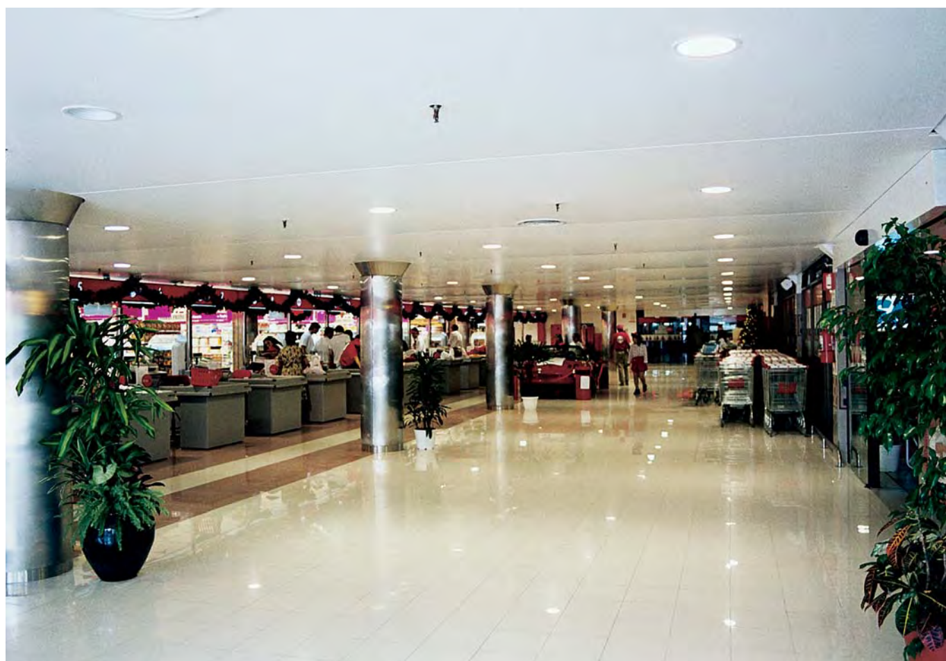
Grande surface habillée de Barrisol avec intégration des éléments techniques et luminaires.
