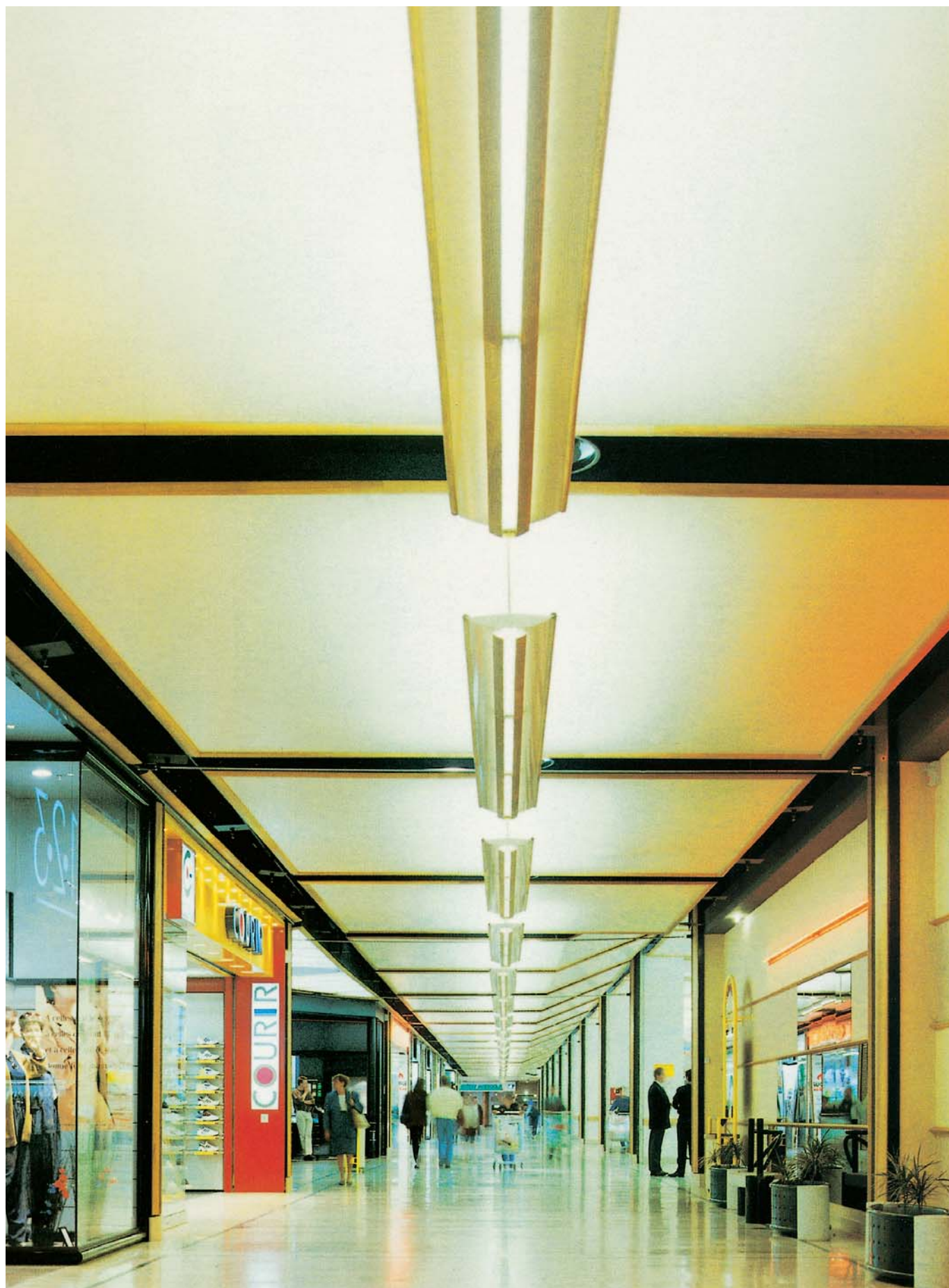
Le Barrisol est monté sur des cadres modulaires installés entre les bouches de climatisation. Une décoration bois a été rajoutée pour donner une finition traditionnelle.
