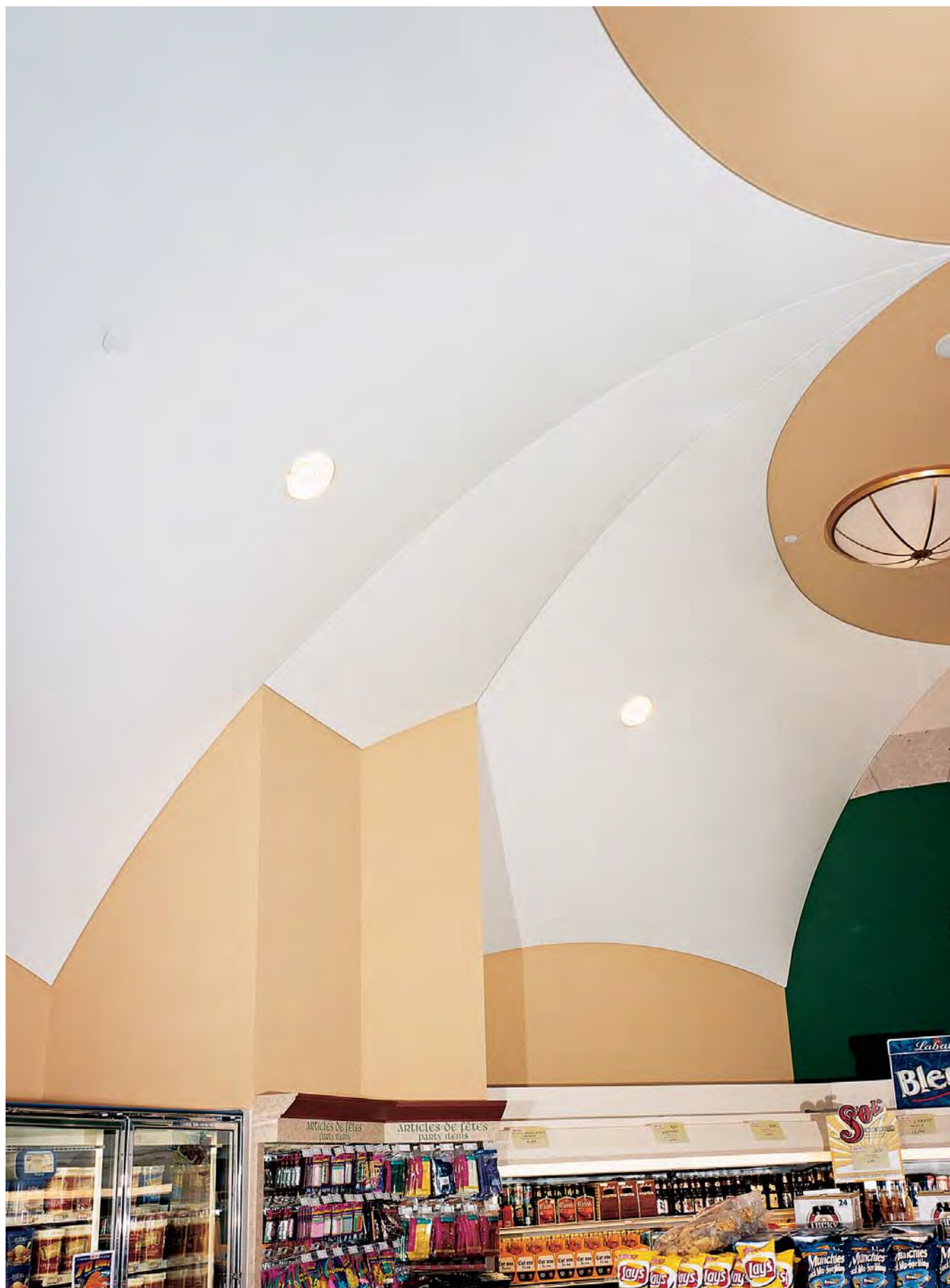
Les plafonds tendus Barrisol sont montés sur les lisses Barrisol préformées afin d'assurer une finition impeccable des joints creux et des connections.
