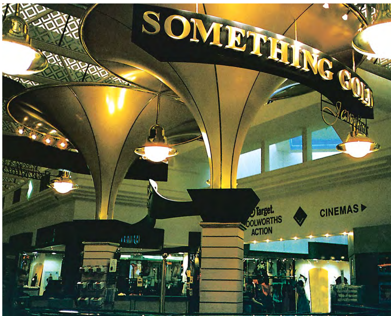
Ces trompettes, réalisées en Barrisol, donnent un volume unique à cet espace.
