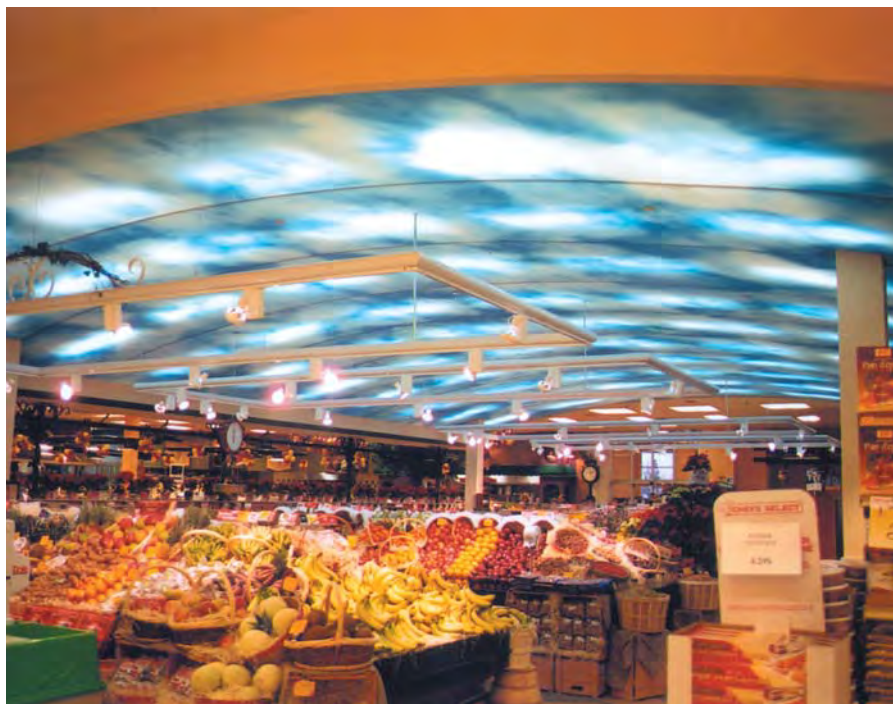
L'effet nuages est peint sur le Barrisol après son installation.
