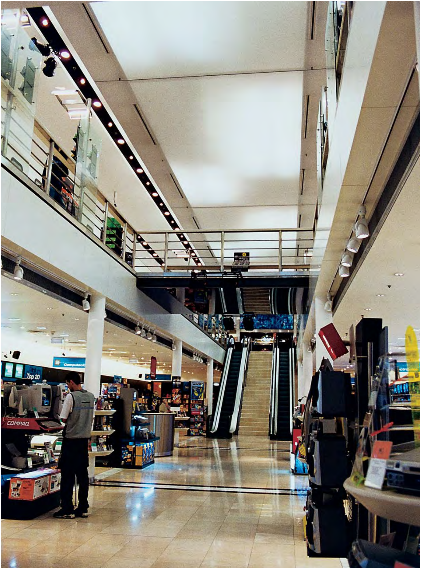
Mélange de Barrisol mat et translucide, la création de zones d'ombres dans le Barrisol translucide donne un effet nuageux.
