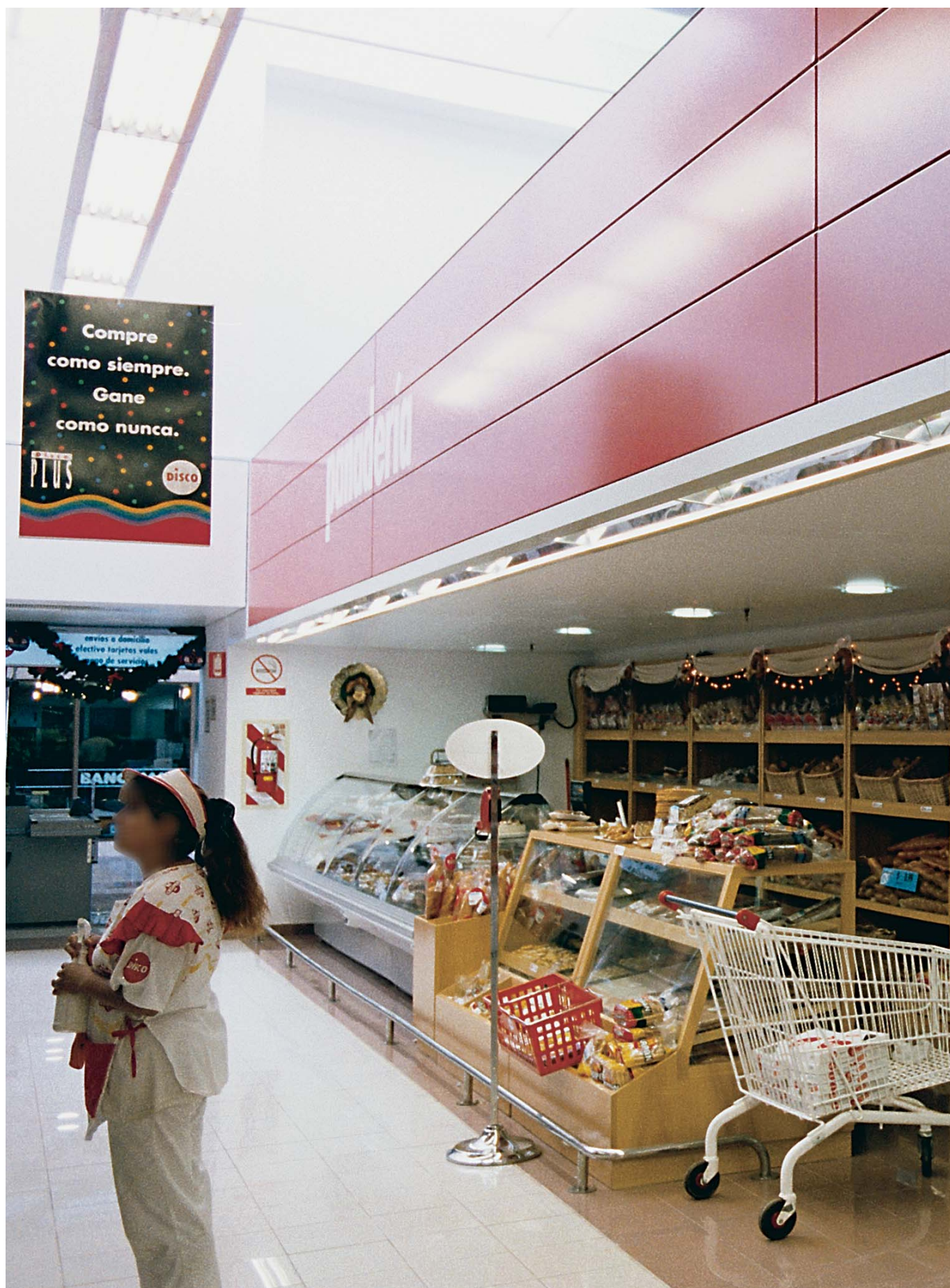
Le Barrisol mural est réalisé en plusieurs parties pour répondre aux souhaits du concepteur du projet. Le plafond Barrisol, grâce aux techniques de fixation Barrisol, est directement placé au sommet du bandeau.
