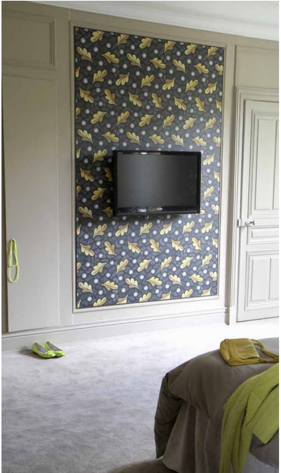
Ref 1033p53. Mur imprimé intégrant les cablages d'une télévision.
