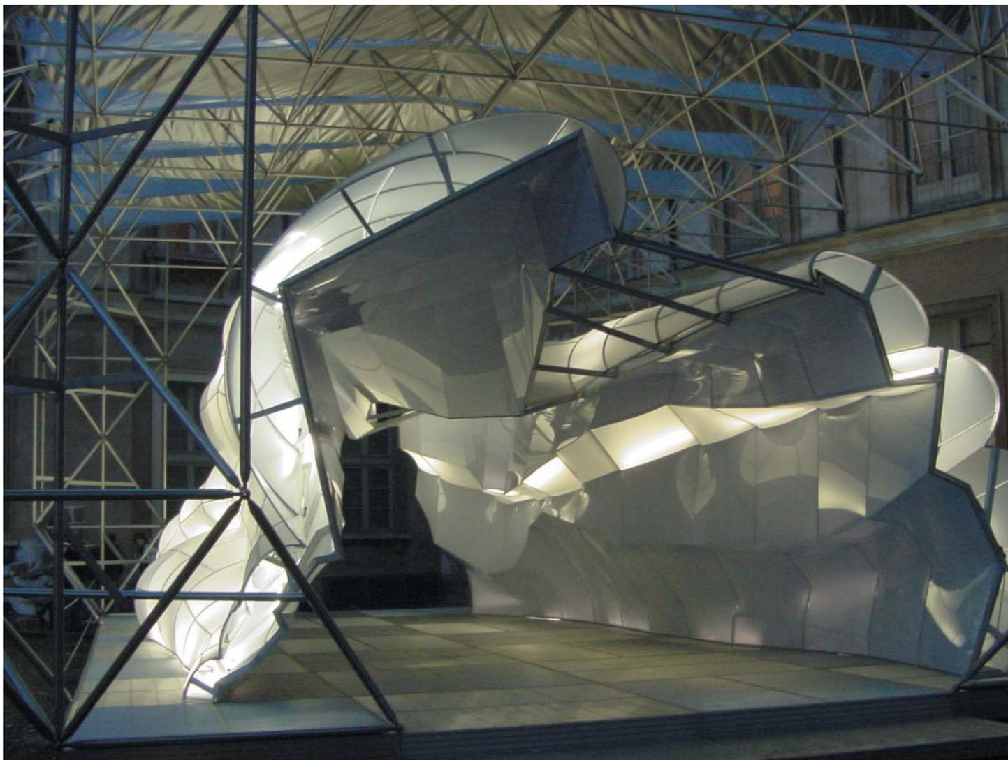
La structure arrondie 3D extérieure est en harmonie parfaite avec la structure intérieure en lignes brisées recouverte de BARRISOL Translucide et Laqué entre la paroi extérieure et intérieure.
